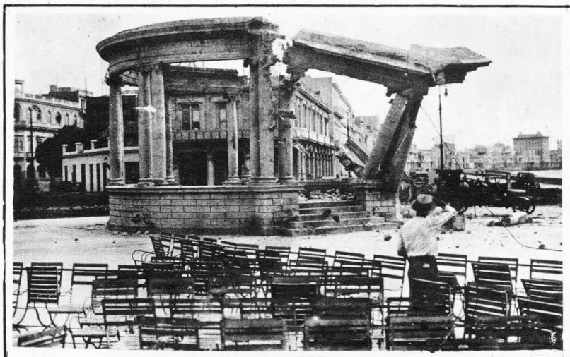
Instantánea tomada en el momento en que se derrumbaba un costado de la vieja Glorietta del Malecón, que fué destruída, por hallarse en estado ruinoso.
